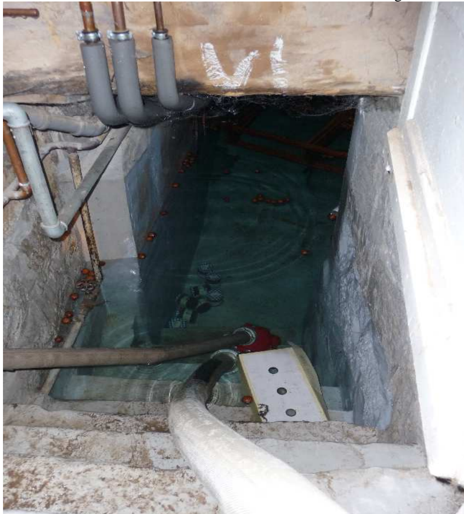
Die Wasserstrahlpumpe war am Kellereingang eingesetzt.
