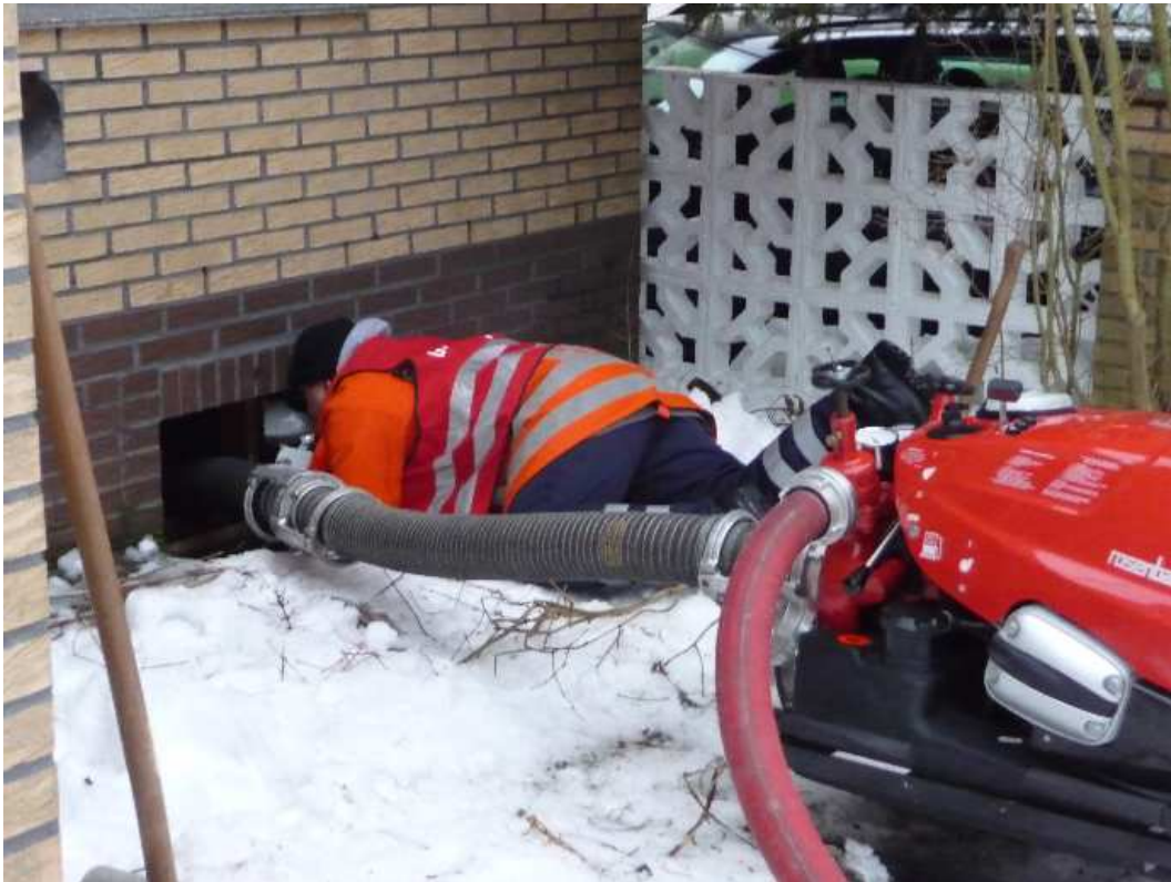
Unsere TS leerte den Keller vom Fenster aus. Unser OrtsBM hat die Lage immer im Auge.
